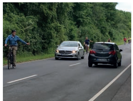
Fehlender Radweg an der Straße nach Klein-Winternheim
